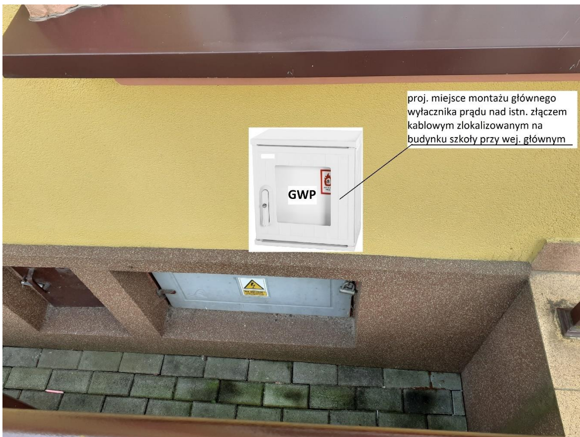
foto. projektowana lokalizacja dla głównego wyłącznika prądu GWP
